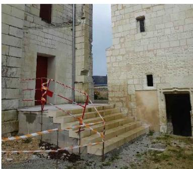
ETAT APRES TRAVAUX - ESCALIER ET PORTE ACCESSIBILITE PMR - FACADE SUD (Garde-corps provisoire à réaliser)
